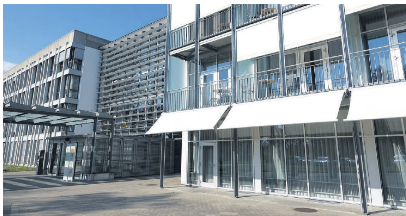
Die Reha Rheinfelden hat eine Isolationsabteilung aufgebaut.
